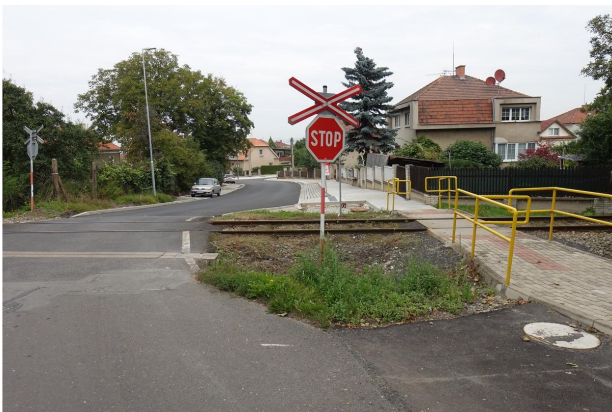
Foto 5 – Pohled na přejezdy P2541 a P2542 ve směru jízdy po komunikaci do centra Roudnice n. L. – za přejezdem je výrazný nenormový zlom v niveletě komunikace a chodníku
