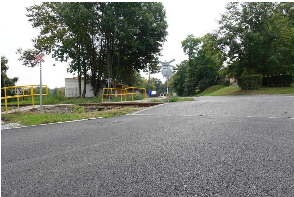
Foto 7 – Pohled na výrazný nenormový zlom v niveletě komunikace a chodníku
