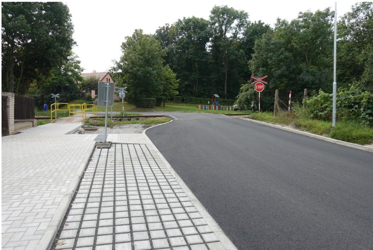
Foto 6 – Pohled na přejezdy P2541 a P2542 ve směru jízdy po komunikaci z centra Roudnice n. L. – před přejezdem je výrazný nenormový zlom v niveletě komunikace a chodníku
