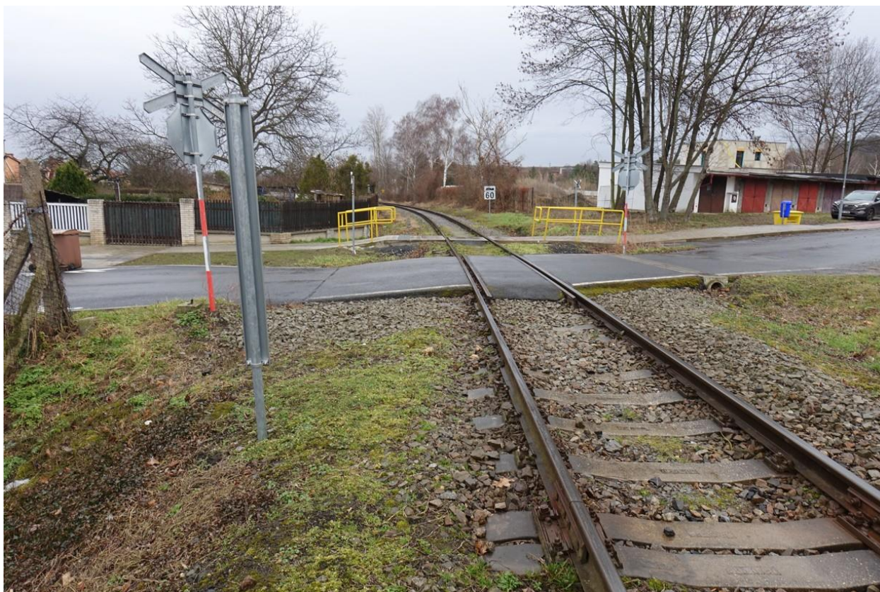
Foto 3 – Pohled na přejezdy P2541 a P2542 – vzájemná poloha koleje a komunikace – vlevo koleje je výrazný nenormový zlom v niveletě komunikace a chodníku
